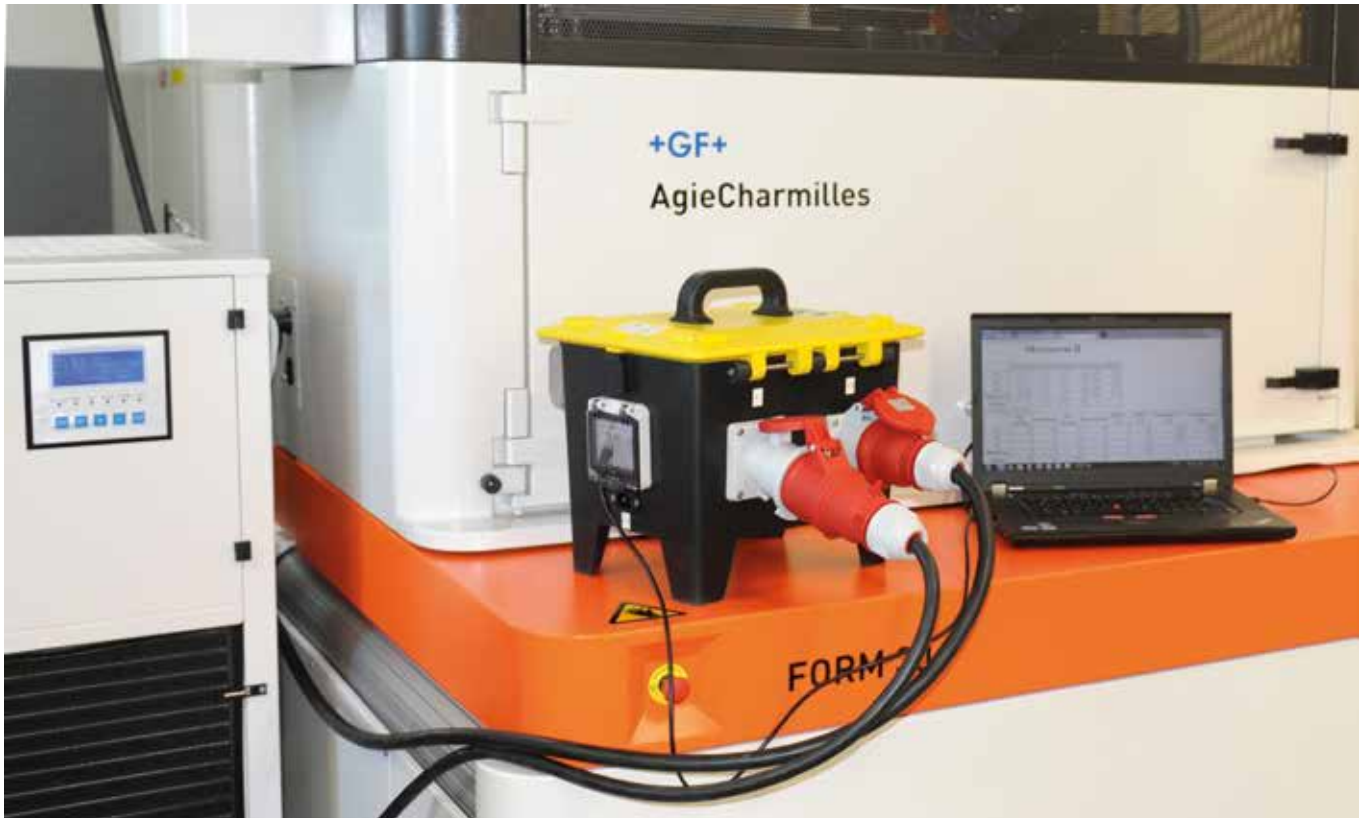
Messen über Maschinenzuleitung mit 16A, 32A oder 63A CEE-Anschluss-technik
